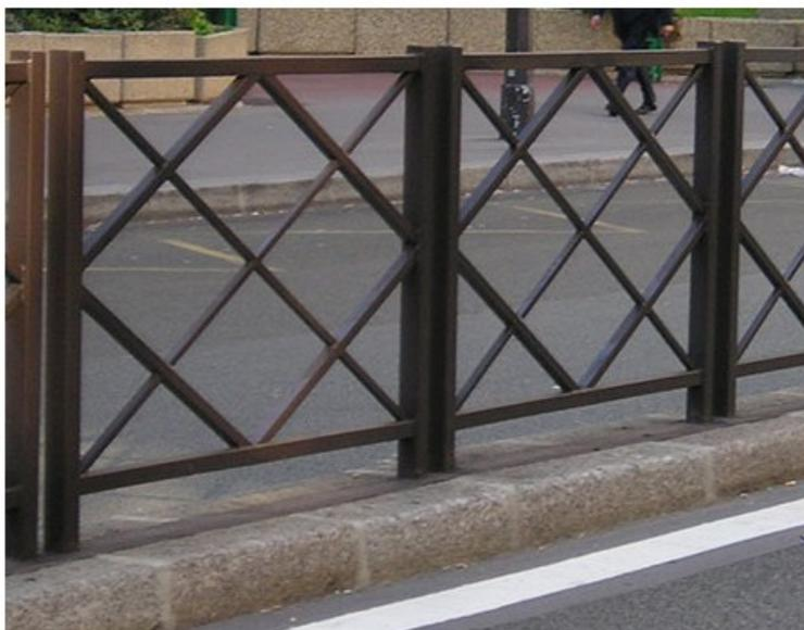
Montants en tube de 50x50 mm. Lisse en tube de 40x40 mm.
