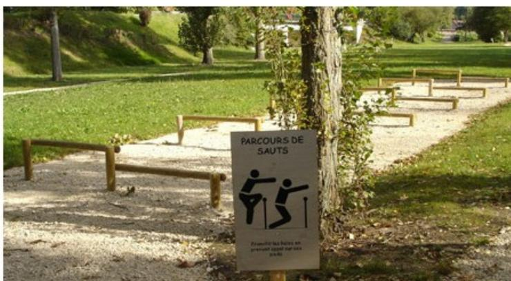
Bois pin du nord Rouge Finlande, catégorie 5, gage de stabilité et de haute résistance. Traitement autoclave classe IV, sans chrome ni arsenic. Principe de l'atelier : franchir les haies en prenant appui sur ses pieds. Zone d'implantation : 18 X 5,1 m. Ensemble composé de 12 haies fabriquées avec des rondins diamètre 8 et 10 cm, 6 sur chaque rangées de largeur 140 cm sur 2 hauteurs 35 et 55 cm. A sceller. Livré avec panneau de consignes.
